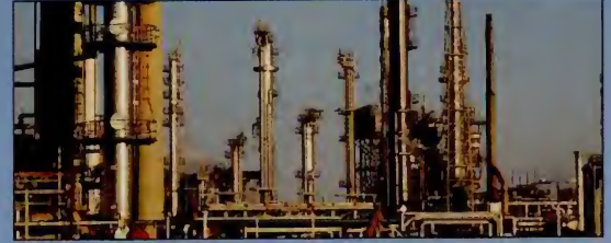
أعمدة التجزئة في مصفاة نفط
